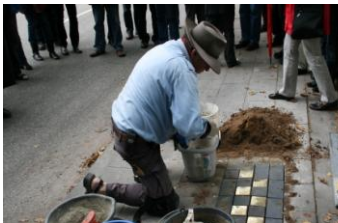
Einsetzen der Stolpersteine in den Gehweg Hoheluftstraße 22
